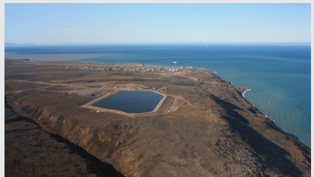
Figure 1. Photographie aérienne de l'étang simple de stabilisation des eaux usées à Pond Inlet, au Nunavut.
