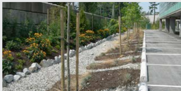
Figure 4. Terrain de stationnement novateur à North Vancouver où les eaux de ruissellement passent à travers un filtre de sable et de gravier
