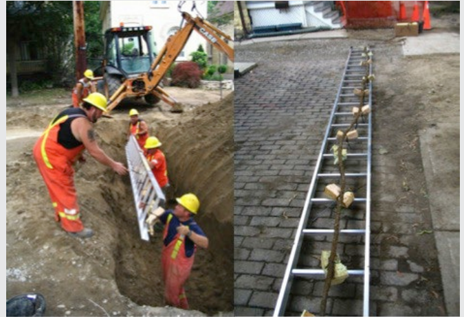
Figure 1 : Enlèvement des canalisations en plomb aux fins de l'étude (Photo : Dan Huggins, ville de London)
